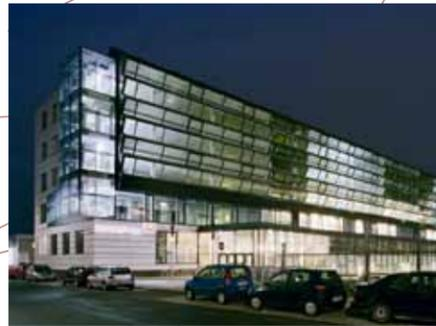
Bei dem zukunftsweisenden Bürogebäude ENERGYbase in Wien-Floridsdorf kann durch die Anwendung des Passivhausstandards und durch den Einsatz erneuerbarer Energieträger (Geothermie, Solarenergie, Photovoltaik) der Energiebedarf um 80 % im Vergleich zu vergleichbaren Bürogebäuden herkömmlicher Bauweise gesenkt werden. © pos Architekten
